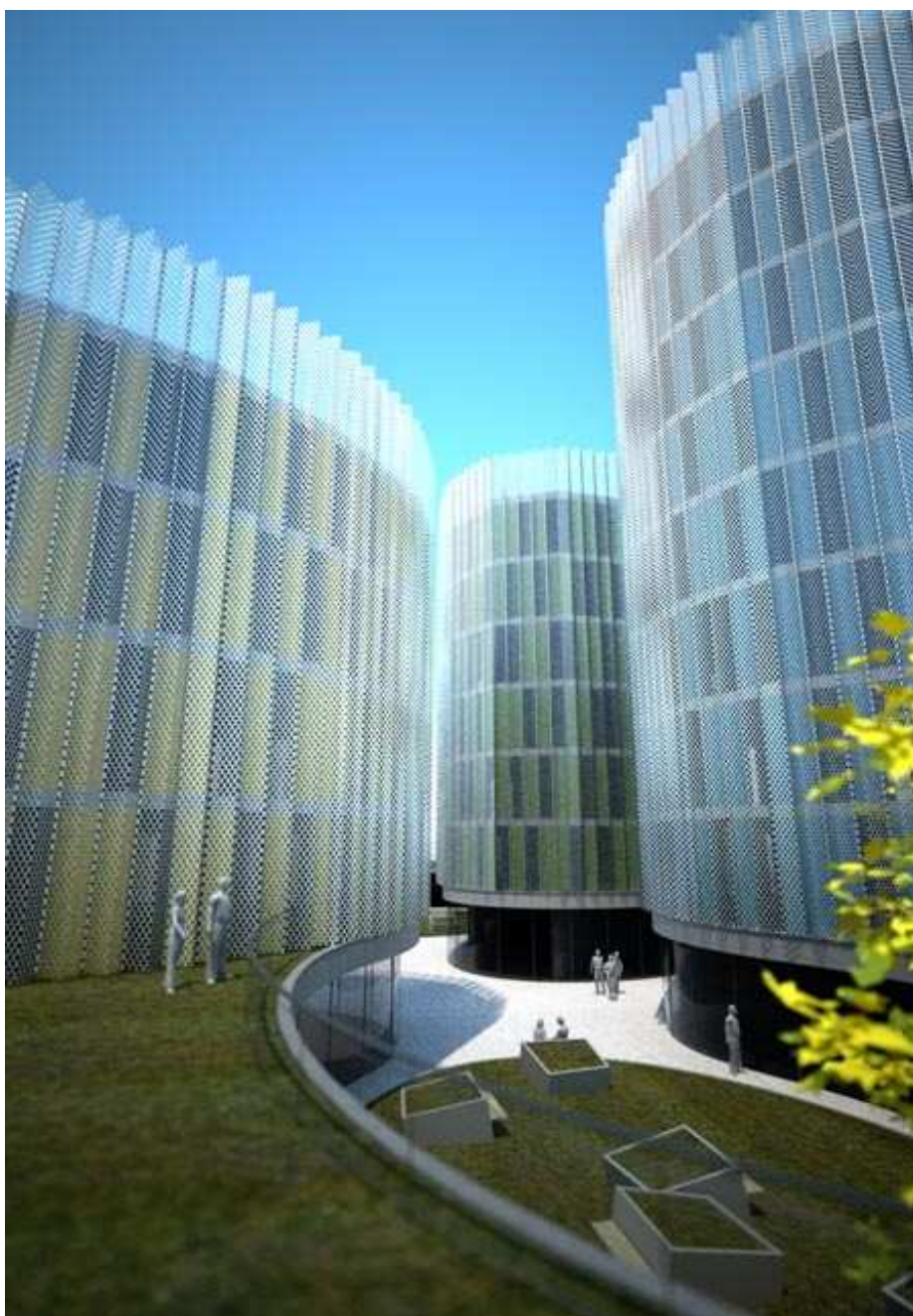
Ilustración 11. Representación tridimensional de los edificios en los que se ubicará la empresa. Fuente: PTFA.
