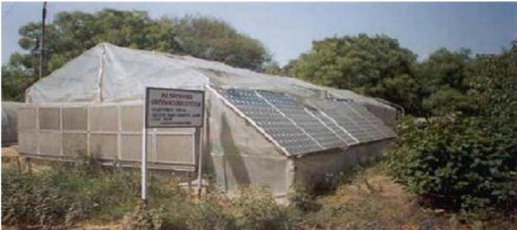
Figura 2.36 Invernadero de Nueva Delhi con módulos fotovoltaicos integrados [37].
