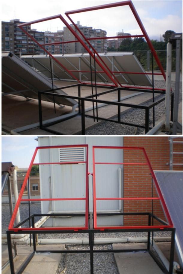
Figura 3.11 Fotografías de la estructura soporte y base de la instalación fotovoltaica experimental.
