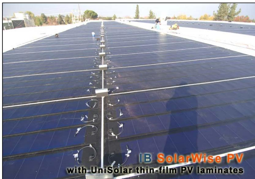
Figura 2.31 Integración de paneles laminados de película fina sobre una cubierta plana.
