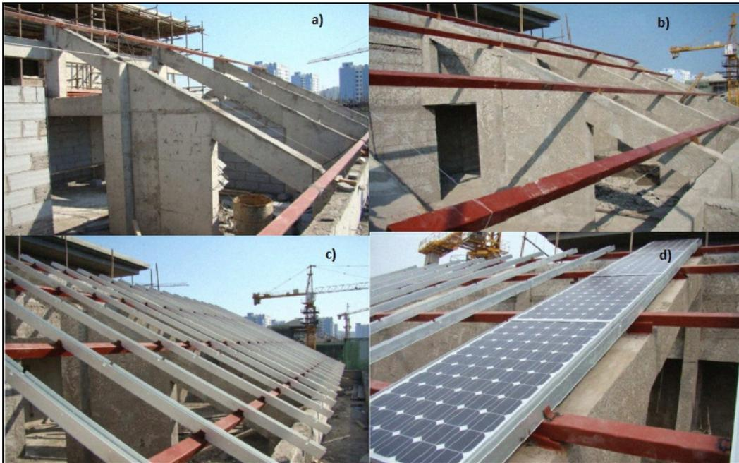
Figura 2.29 Proceso de ingeniería de la integración fotovoltaica en la cara sur de un edificio de China [36].
