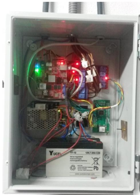
Figura 57. Centralita de control con batería en su armario
