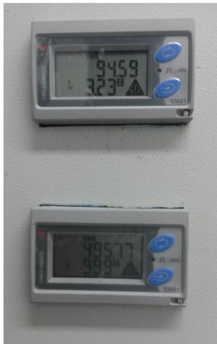
**Figura 59. Medidores de consumo eléctrico conectados con la centralita, el primero específico de la deshumectadora, el segundo corresponde al consumo global**
