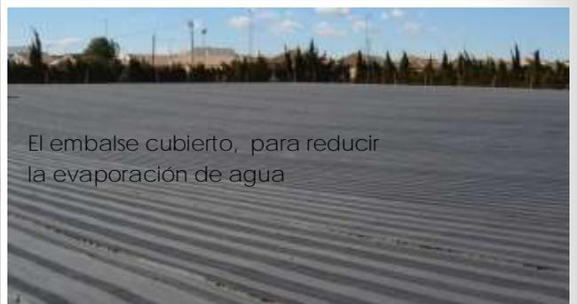
El embalse cubierto, para reducir la evaporación de agua
