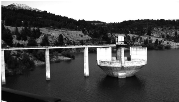
Fig. 1. Vista del aliviadero Morning Glory del embalse del Taibilla
