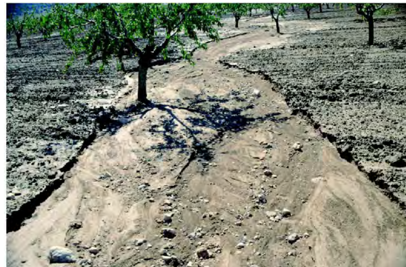
Figura 3. Vista de erosión laminar y en regueros (Romero y Alonso, 2007).
