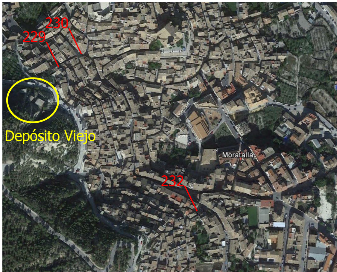
Figura 11 | Ubicación sobre ortofoto de las tuberías más relevantes en el sector Depósito Viejo .
