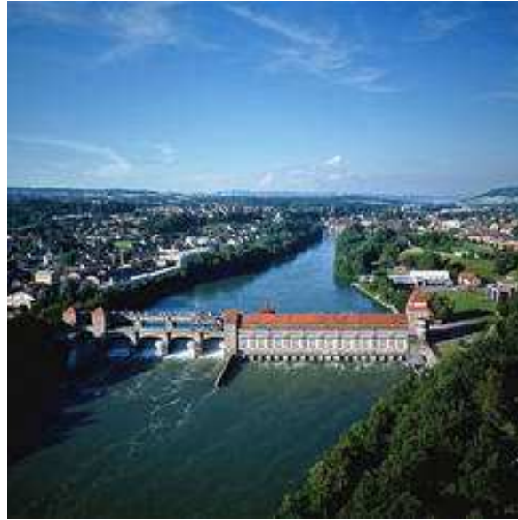
Figura 4: Central hidroeléctrica de Laufenburgo, Argovia, Suiza.
