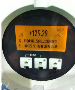
**Figura 2.16.** Caudalímetro instalado a la entrada del circuito.
