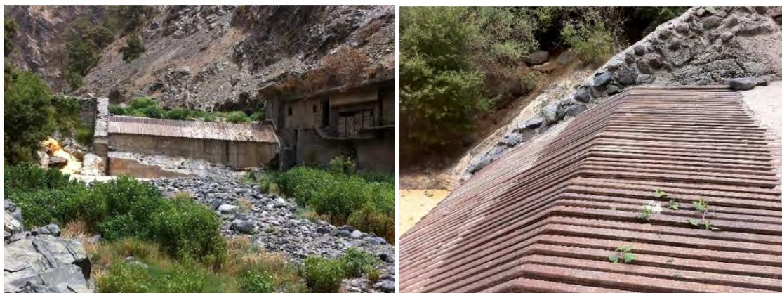
**Figura 1.1.** Izqda: Vista de obra de captación de fondo en cauce efímero. Tomadero de Dos Aguas, Barranco de Las Angustias, Isla de La Palma. (Islas Canarias España). Dcha: Detalle de la reja de fondo formado por barras longitudinales al flujo.
