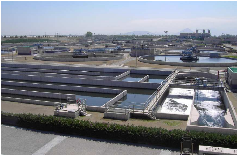
Figura 78: Ejemplo de un canal de cloración. Fuente: Internet.
