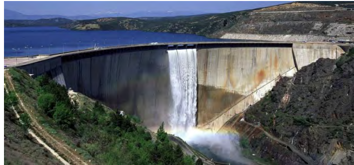
Figura 5.1. Vertido por coronación en la presa del Atazar (Madrid) ( www.diegosalvador.com )
