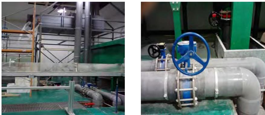
**Figura III.2: (a) Conducciones en presión; (b) Detalle de la válvula de mariposa.**
