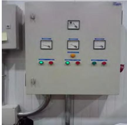
**Figura III.8: Caja eléctrica que regula las bombas.**
