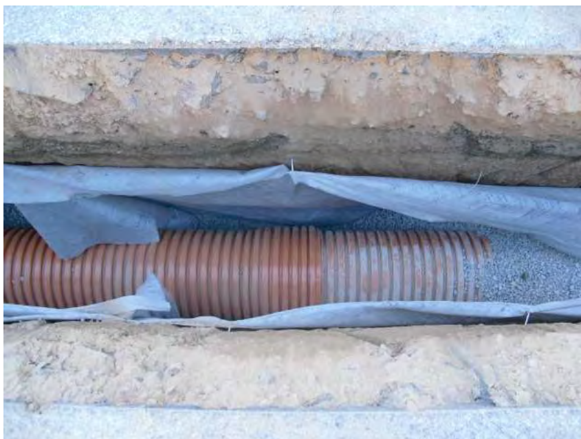
Figura 6-15. Detalle instalación zanja drenante
