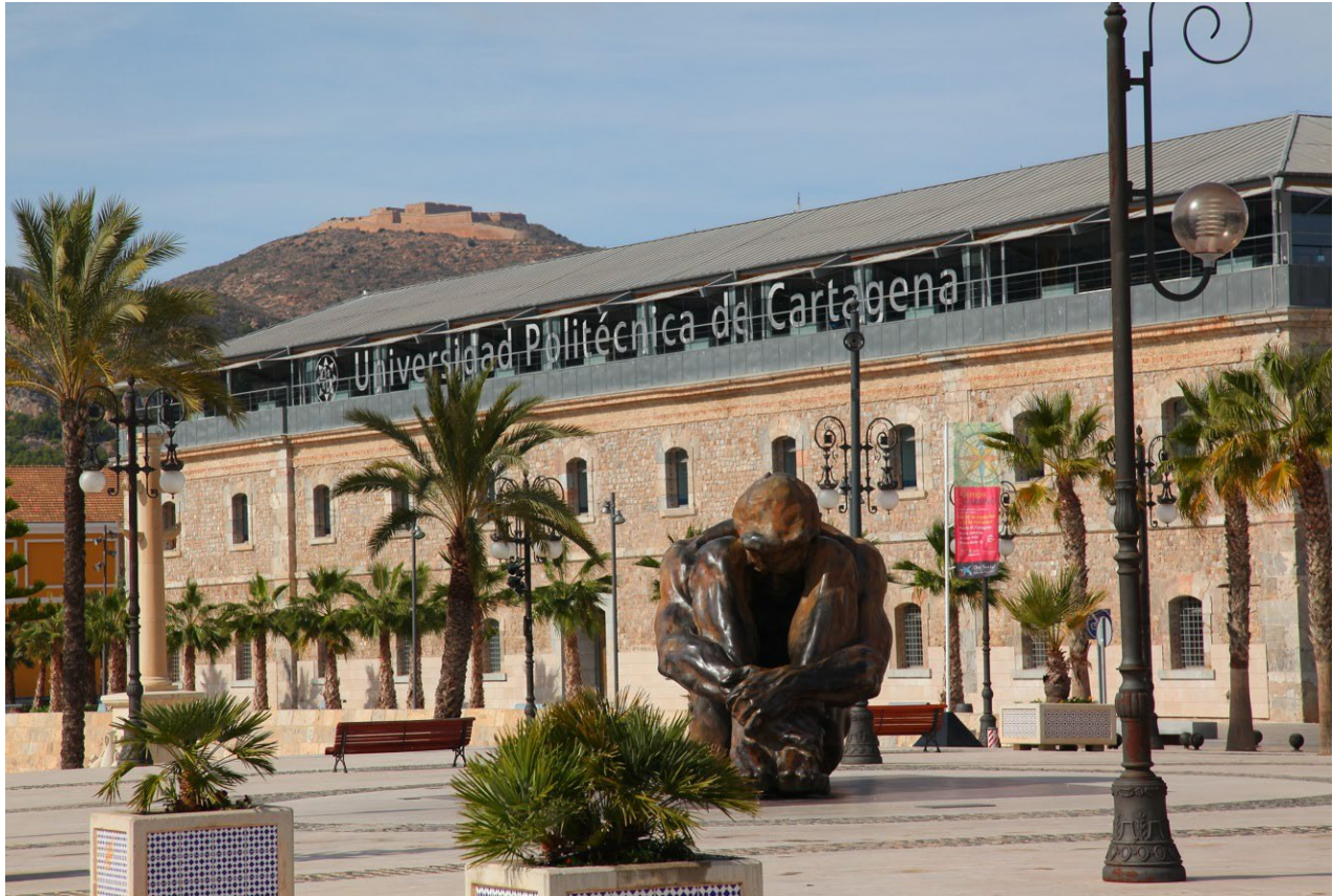
FACHADA LATERAL DE LA FACULTAD DE CIENCIAS DE LA EMPRESA (CIM) DE LA UNIVERSIDAD POLITÉCNICA DE CARTAGENA
