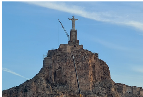
Castillo de Monteagudo. Montaje de andamios en el frente sur. Autor: Francisco José Sánchez Medrano.
