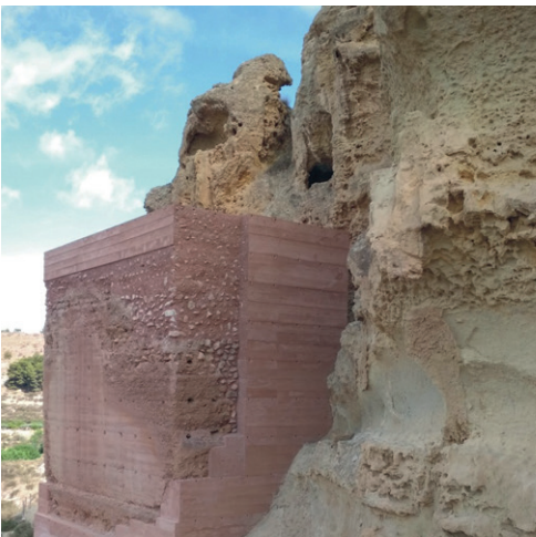
Torre del Agua, en Aledo, después de la restauración. Autor: José Antonio Sánchez Pravia.
